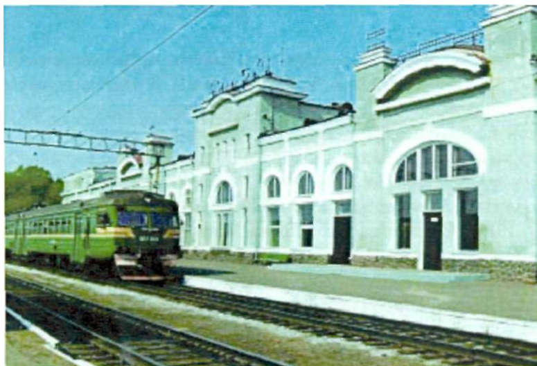
Рис. 58. Железнодорожная станция Томск-I (фото Л.К. Черникова)
