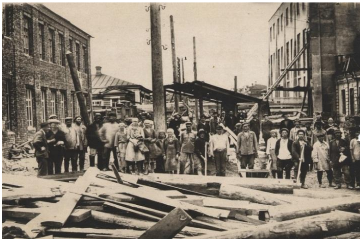
Городская электростанция. Работы по монтажу котла
