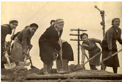
Женщины на укладке рельсов городской железной дороги
